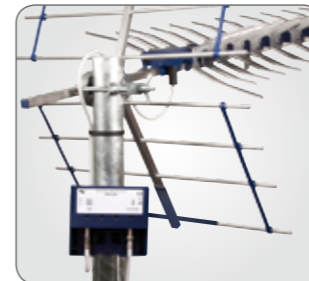
Monter forsterkeren på masten
